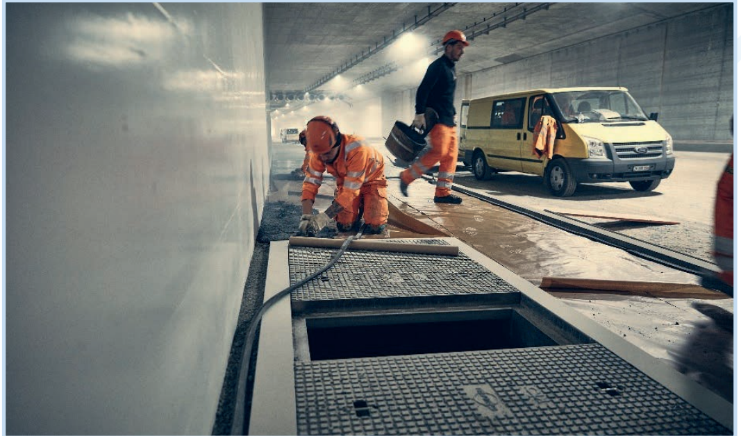
Einbau eines Kabelzugschachtes mit Verbundwerkstoff in der Einhausung Schwamendingen
