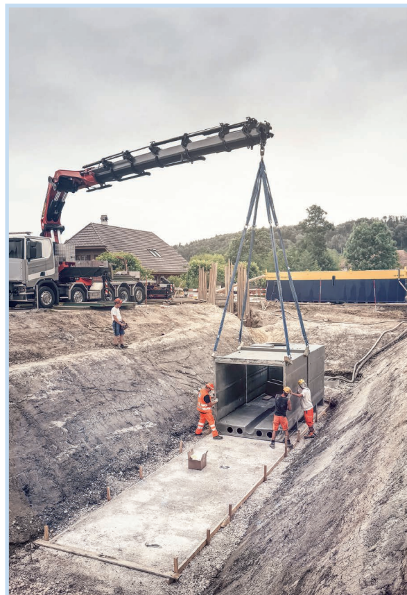
vorfabrizierter Mischwasserkanal, Diessbach
