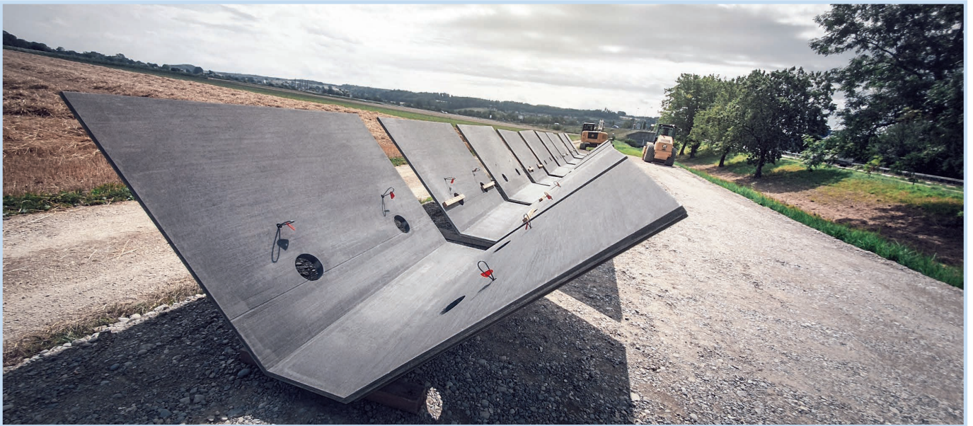
vorfabrizierte Bachelemente, Sanierung Aarmattenkanal Grenchen
