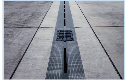
Anti-Rutsch Oberfläche auf Schwerlastrinne mit integriertem Spülelement
