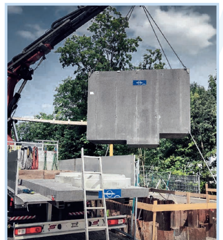
vorfabrizierter Pumpschacht, Bottmingen
