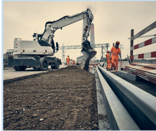
Einbau und Hinterfüllung von Schlitzrinnen im Projekt Einhausung Schwamendingen, 2023
