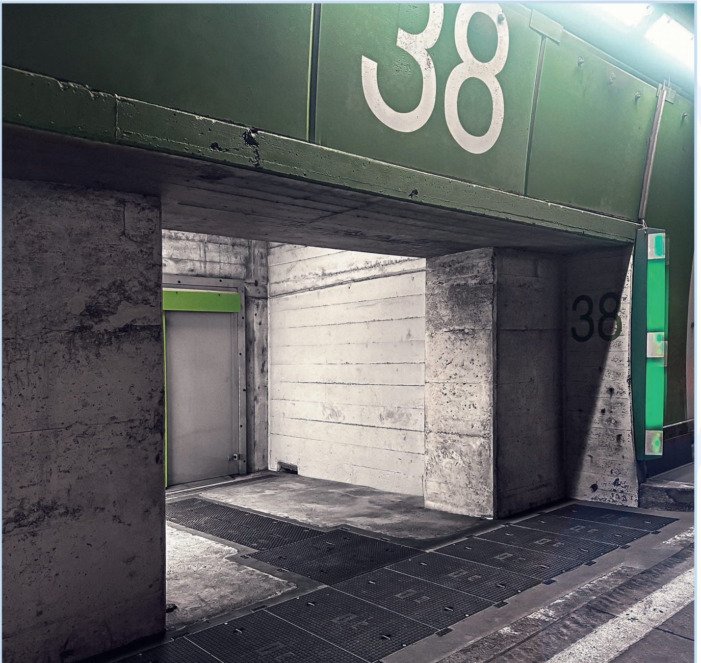
Massanfertigung Schachtabdeckung Verbundwerkstoff, Seelisbergtunnel
