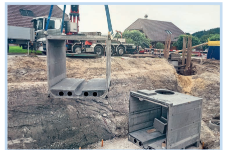
vorfabrizierter Mischwasserkanal, Diessbach
