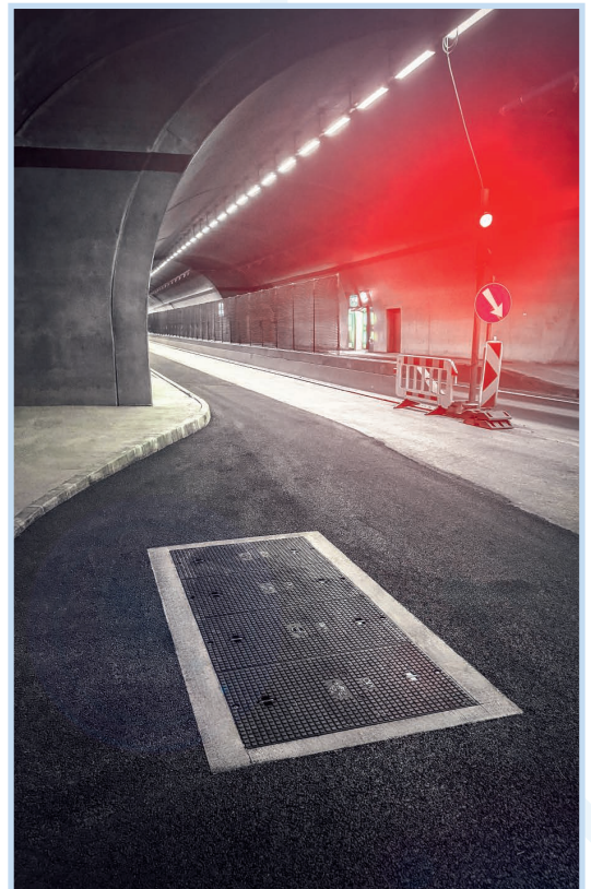
Einbau eines Kabelzugschachtes mit Verbundwerkstoff in der Einhausung Schwamendingen
