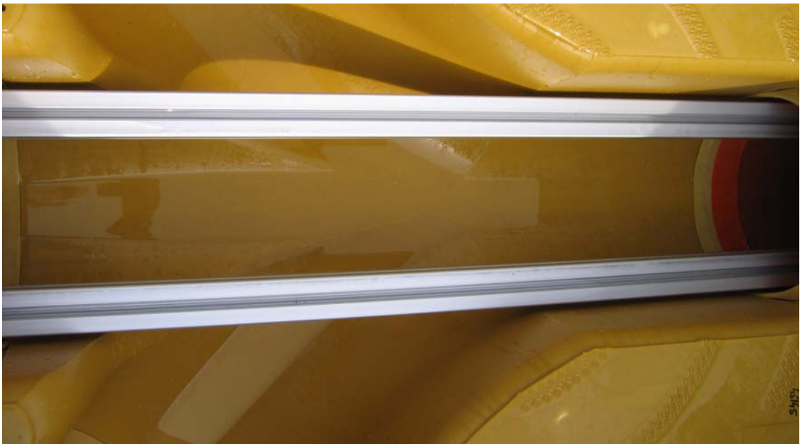
Abbildung 6: PP-Schacht nach 50 Rohrlängen
