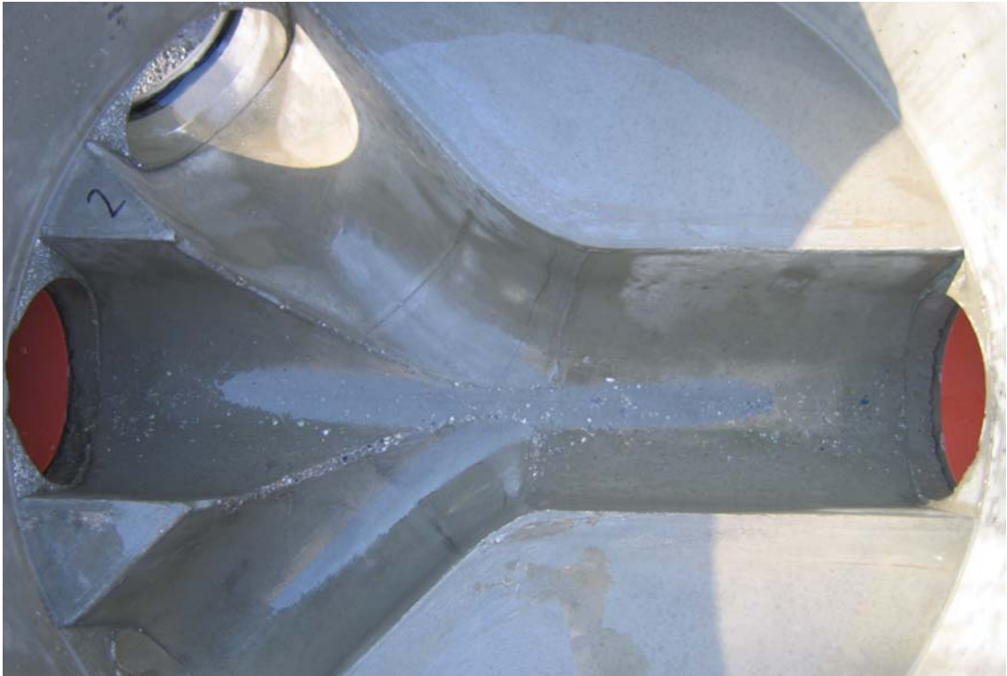
Abbildung 39: Betonschacht DN 250 nach 50 Rohrlängen
