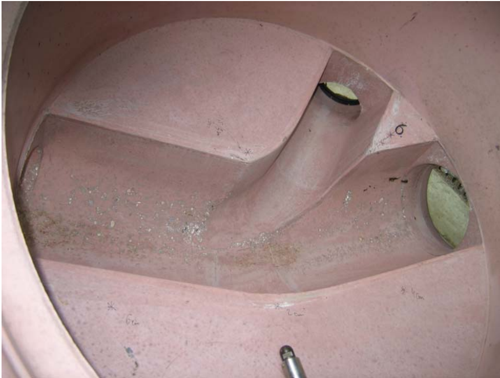
Abbildung 23: Schacht aus Hochleistungsbeton
