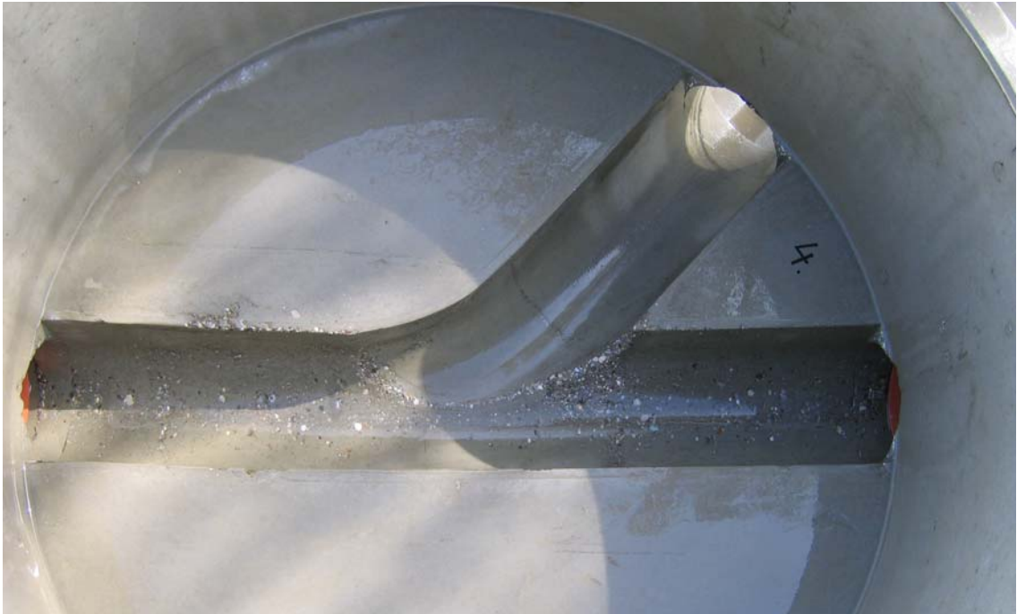
Abbildung 31: Betonschacht nach 50 Rohrlängen
