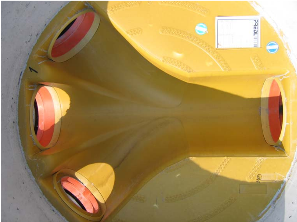
Abbildung 2: Fertigteilschacht mit tiefgezogener Schachtauskleidung aus PP
