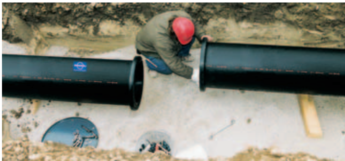
Erst vor Montage Flanschschutzdeckel entfernen, Sitz der Dichtung kontrollieren. Von allfälligem Schmutz säubern.
