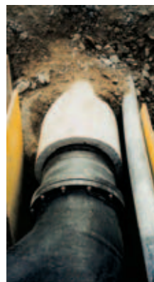
Übergang auf Betonrohr.
