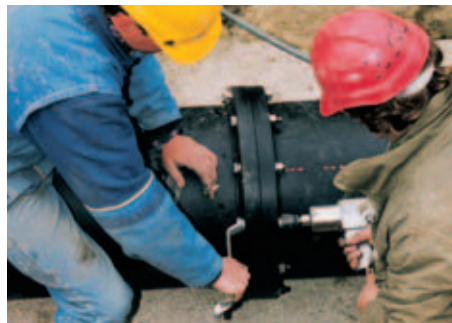
Verschrauben der Rohre über's Kreuz, wie beim Radwechsel am Auto.
