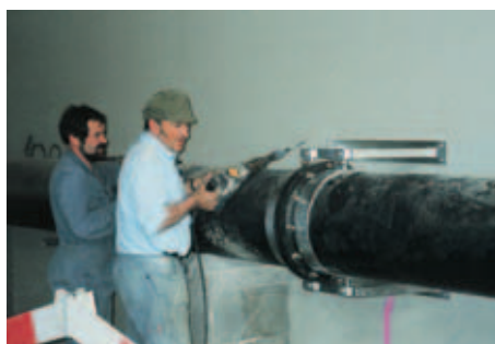
Rohrbriden aus Metall für Aufhängungen/Montagen (Verzinkt oder Inox).
