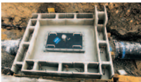
Kontrollöffnung im Schacht, nach Einbetonieren, vor Erstellen des Kontrollschachtes.
