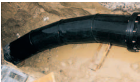
Richtungsänderungen mit Bögen jeden Winkels möglich.
