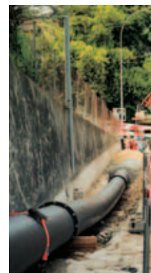
Lange Biegeradien können direkt mit dem Rohr (ohne Formteile) ausgeführt werden.
