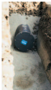
Flanschschutzdeckel müssen bis zum Schluss montiert bleiben.
