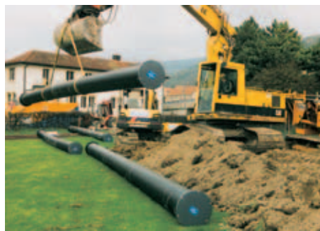
Verteilen der Rohre entlang der Linienführung, auf ebener Auflage.
