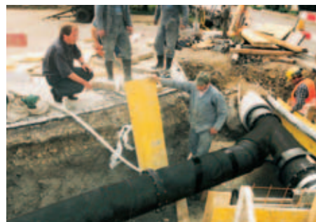
Vorfabrizierte (montagefertige) Rohrteile ab Werk möglich, soweit transportierbar.
