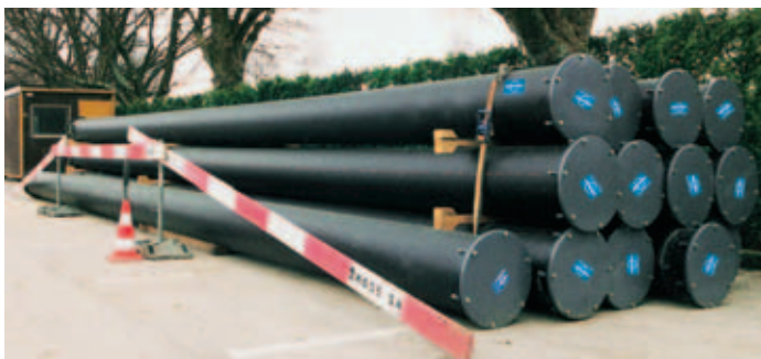
Rohrlager: Das Erstellen eines sorgfältigen Rohrlagers ist wichtig, damit die Rohre gerade bleiben und nicht ovalisiert werden. Alle 2 m mit breiten Kanthölzern unterlegen.
