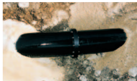
Vor der Druckprobe: Rohre können eingedeckt werden, nur Flanschen müssen zugänglich bleiben. Nach der Druckprobe: Alle Flanschen generell (bei allen Serien) Profil IV einbetonieren. Die einbetonierten Flanschen dienen zugleich als Fixpunkt, bzw. Leitungsfixierung.
