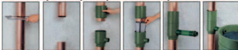
Passt zu verzinkten, Kupfer- oder Kunststofffallrohren, aussen Ø 73–87 mm bzw. 98–110 mm.
